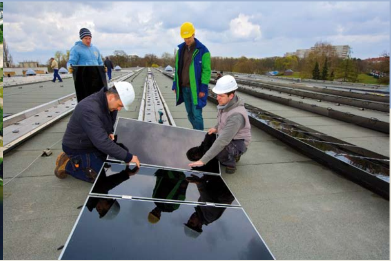
Mitarbeiter der eleven solar GmbH Berlin montieren mehr als 2.600 Module auf die Unterkonstruktion.
